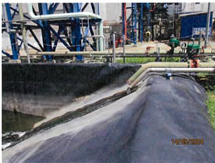
ภาพที่ 2-21 ระบบกระจายน้ำที่บริเวณจุดปล่อยน้ำทิ้ง
