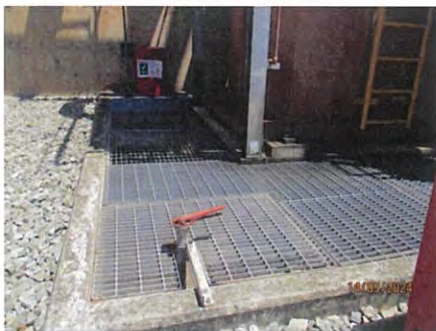
ภาพที่ 2-27 จุดระบายน้ำฝนที่เชื่อมต่อกับ ระบบระบายน้ำฝนของนิคมฯ
