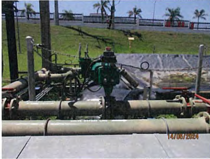
ภาพที่ 2-19 วาล์วควบคุมการปล่อยน้ำทิ้งจากหอหล่อเย็น
