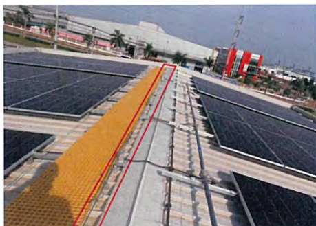
ภาพที่ 2-66 สาย Life Line บริเวณหลังคาอาคาร
